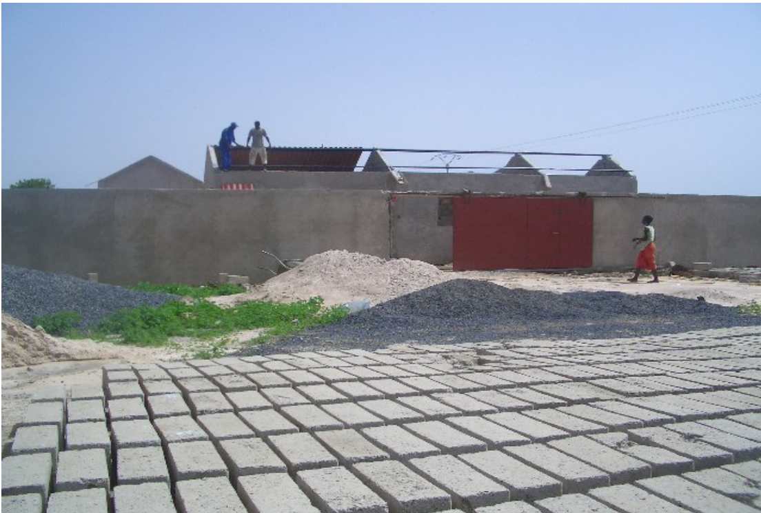
Construyendo el tejado y puerta de entrada
